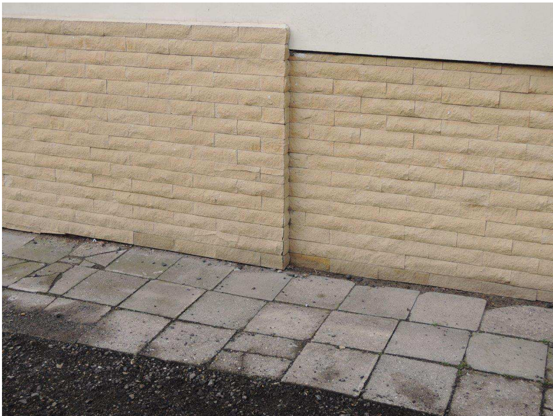
Foto č.12 – Pohled na východní část fasády – obložení základů objektu
