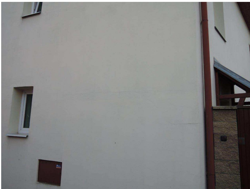
Foto č.7 – Pohled na severní část fasády – větší trhliny tloušťky cca 1mm
