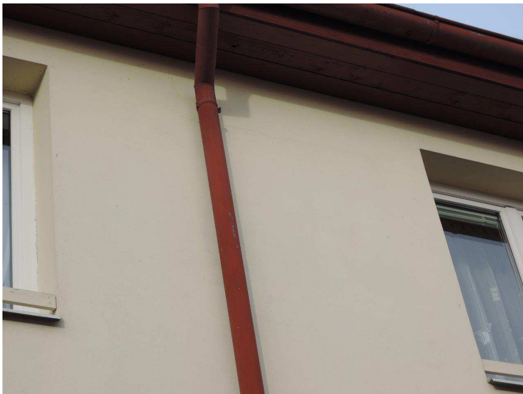
Foto č.14 – Pohled na východní část fasády – větší trhliny tloušťky cca 1mm
