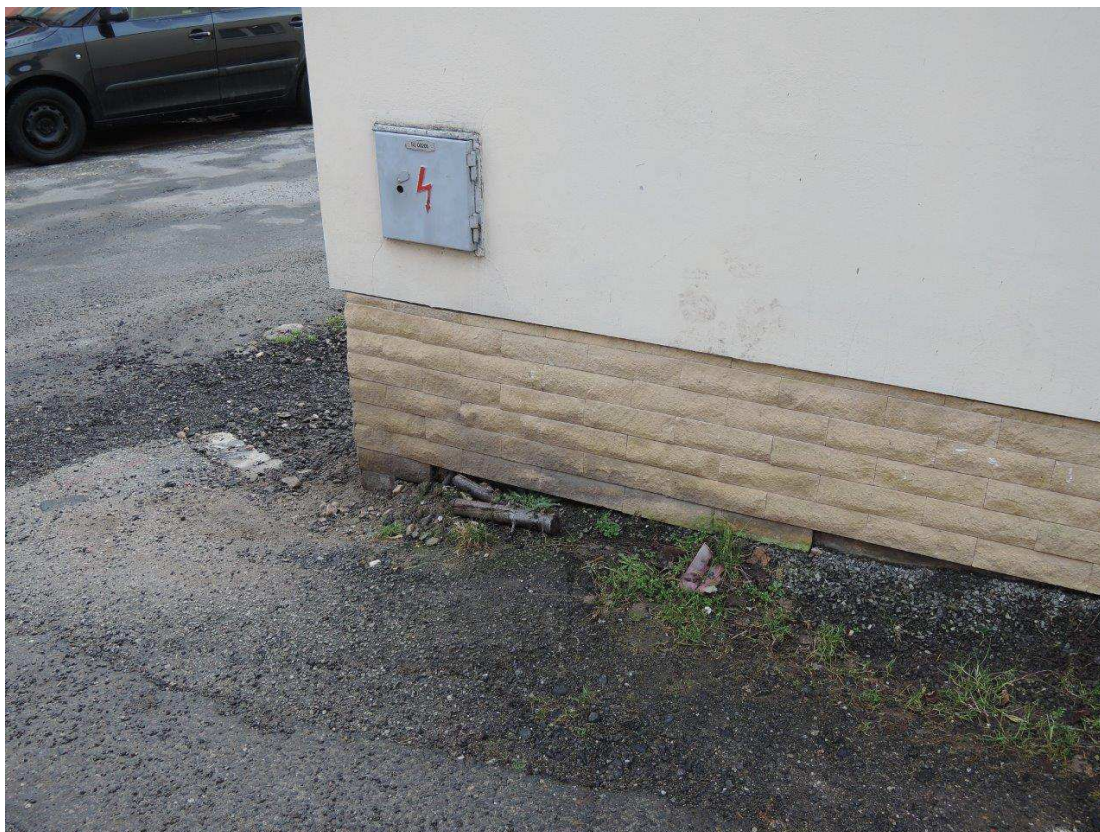
Foto č.10 – Pohled na severní část fasády – vlhkost u základů objektu
