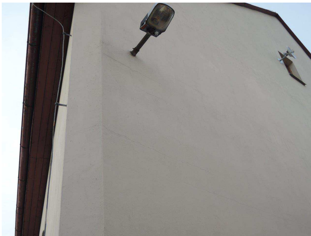
Foto č.11 – Pohled na severní část fasády – větší trhliny tloušťky cca 1mm
