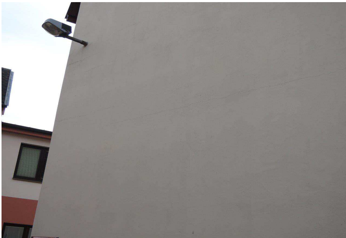
Foto č.9 – Pohled na severní část fasády – větší trhliny tloušťky cca 1mm
