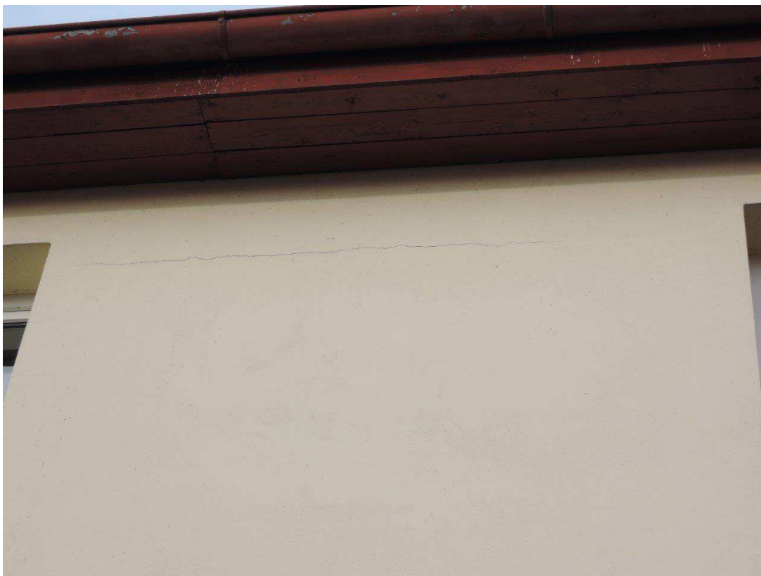
Foto č.13 – Pohled na východní část fasády – větší trhliny tloušťky cca 3mm
